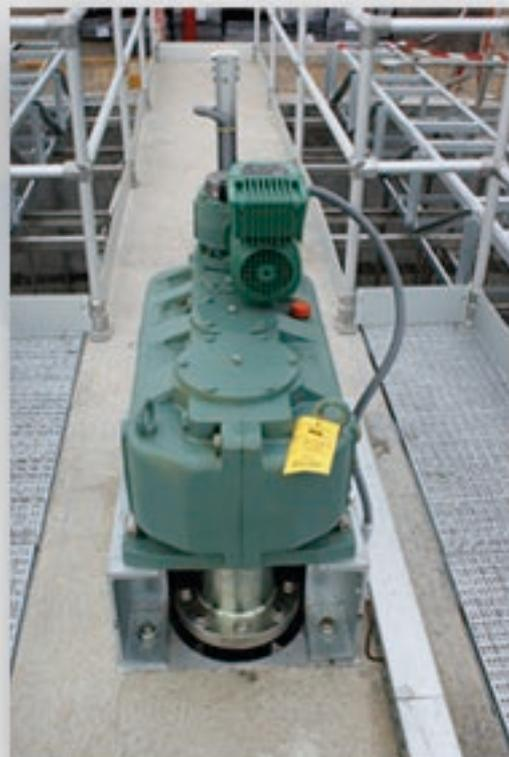
A partir de un sistema de tracción con eje central, anclado en el puente, se consigue actuar las palas inferiores, las cuales efectúan la recogida de los lodos inferiores.
